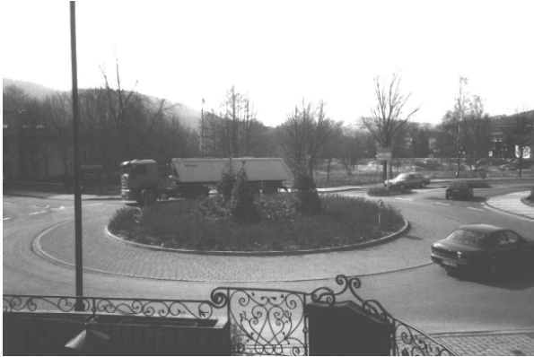
Kreisverkehr am Ortseingang: Eine verkehrsgerechte, zukunftsorientierte Lösung in Drolshagen
