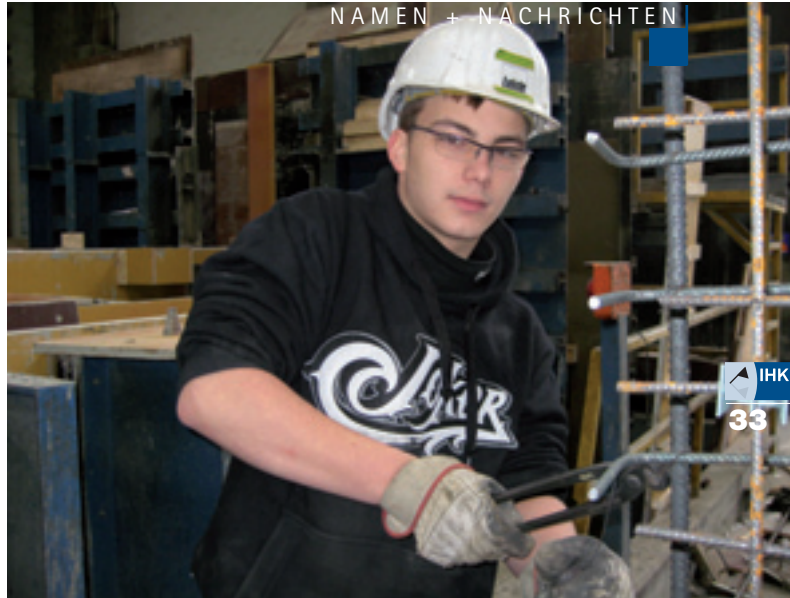
Praktikant André Geise beim Flechten von Stahlbewehrungskörben.
